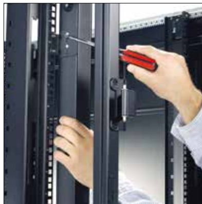
PDU ブラケットを使用した取り付け
